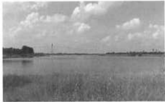
(ง) จุดที่ ๔ บ่อน้ำสำรอง ขนาด ๔๐๐ ไร่
